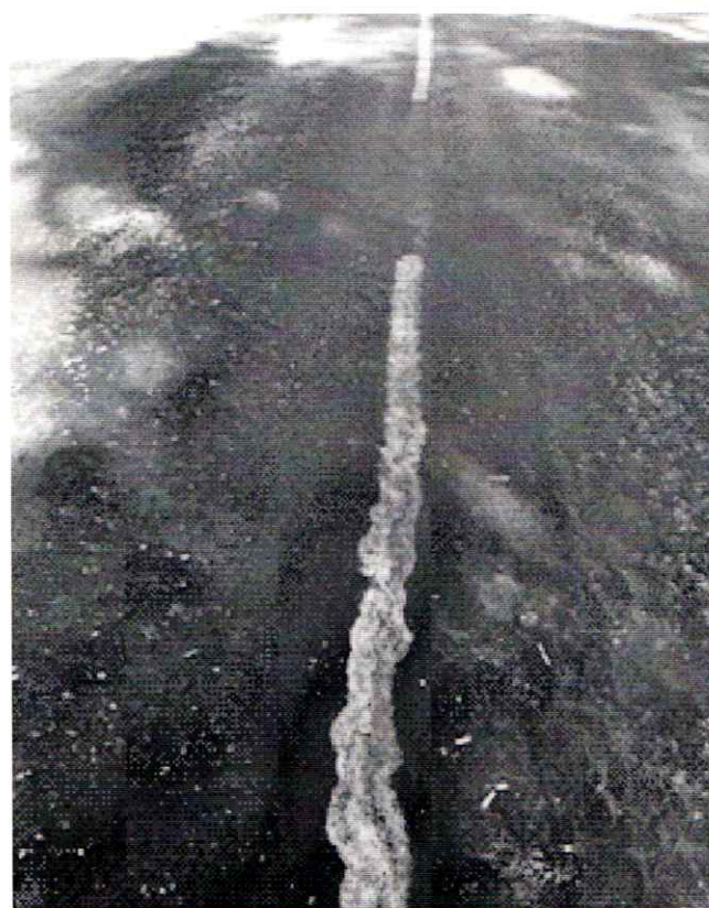
Рис. 1. Ділянки автомобільної дороги, на яких спостерігається випотівання бітуму
